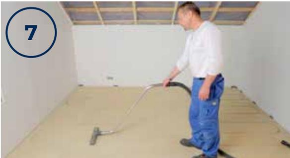
Toutes sciures de bois et autres saletés sur le plancher et dans les rainures des tuyaux devront être nettoyées avant d'installer les plaques de transfert thermique.
