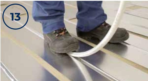
Installez les tuyaux de chauffage dans les rainures des plaques de transfert thermique. Assurez-vous que le tuyau est entièrement encastré dans la rainure afin d'éviter qu'il ne supporte le poids du plancher apparent.
