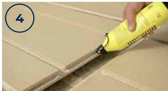
Les panneaux doivent toujours être collés les uns aux autres sur la languette et la rainure. Les panneaux peuvent également être collés sur la base pour éviter d'éventuels craquements. Utilisez une colle à bois PVA appropriée. Appliquez soigneusement la colle en vous assurant qu'il y a un joint continu d'adhésif sur toute la longueur de la languette et de la rainure. Notez cependant qu'un excès de colle risque de créer des espaces entre les panneaux.
