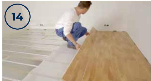
Il est possible de poser du parquet ou du stratifié directement sur les plaques de transfert thermique et l'isolation phonique. Avec d'autres matériaux de surface, il faudra utiliser des panneaux de construction d'au moins 6 mm d'épaisseur.
