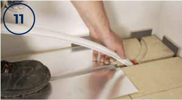
L'installation du tuyau de chauffage commence en le faisant passer à travers le plancher jusqu'au collecteur.
