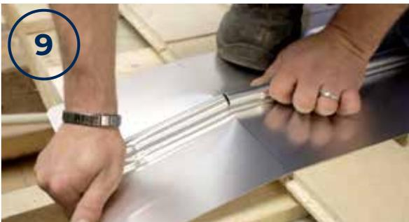
Utilisez les points de pliage pour couper les plaques aux bonnes dimensions. Redressez s'il y a lieu les coins recourbés des plaques avant l'installation.
