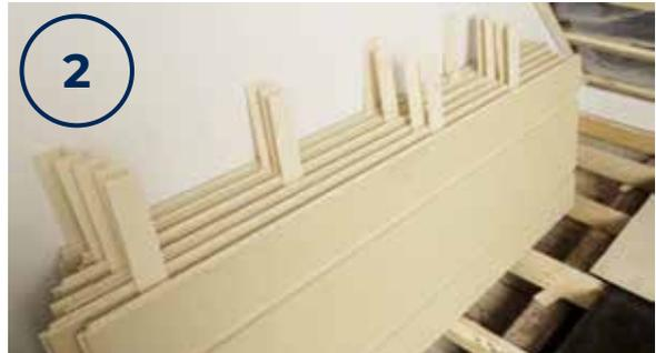
Avant l'installation, le taux d'humidité des panneaux KoskiTherm doit être stabilisé à un niveau similaire à celui des conditions d'utilisation. Cela prend 5 à 7 jours, selon le taux d'humidité initial. Les panneaux doivent être séparés par des lattes pendant ce processus.
