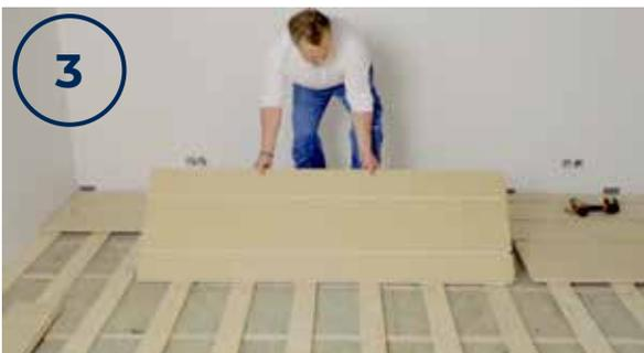
Il est conseillé de commencer l'installation depuis l'endroit le plus éloigné du collecteur d'eau afin de faciliter l'installation des tuyaux de transfert entre la tuyauterie et le collecteur.
