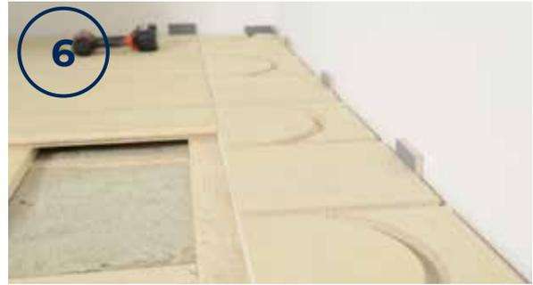
Pour permettre la dilatation naturelle du bois à l'usage, les panneaux doivent être posés de manière à ménager un espace d'au moins 10 mm entre les panneaux et les murs et entre les pièces. Si les panneaux KoskiTherm sont posés directement sur les lattes, le joint d'extension d'un panneau avec virage doit être installé et vissé sur les lattes. Lors de l'installation sur des planches espacées, le joint d'extension d'une plaque avec virage ne doit pas nécessairement se trouver sur les lattes.
