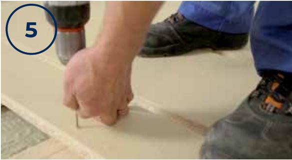
Les panneaux KoskiTherm doivent être vissés sur la base à l'aide de vis à bois. Les vis doivent être à tête fraisée et d'une longueur de 50 à 75 mm. Elles sont fixées sur le milieu et sur les bords des panneaux à 300-450 mm d'intervalle.
