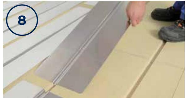
Les plaques de transfert thermique sont installées par pression sur les sections droites des panneaux KoskiTherm. La distance entre les plaques de transfert thermique doit être de 10 à 100 mm. Il n'est pas nécessaire de fixer les plaques de transfert thermique sur la base.
