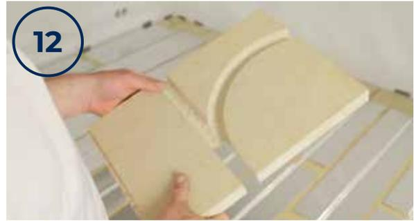
Fraisez les entrées avant l'installation des panneaux ou directement sur la surface du plancher.
