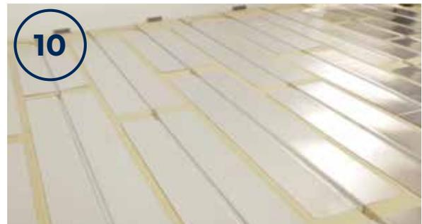
Les plaques de transfert thermique doivent recouvrir 70 à 90 % de la surface de plancher. Le plancher doit être nettoyé une fois de plus avant l'installation de la tuyauterie.
