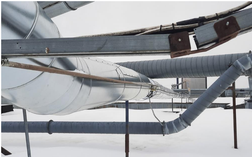
Kuva 137. Äänilähde 134. Puruputki. Putkiston äänieristys aloitettu.
