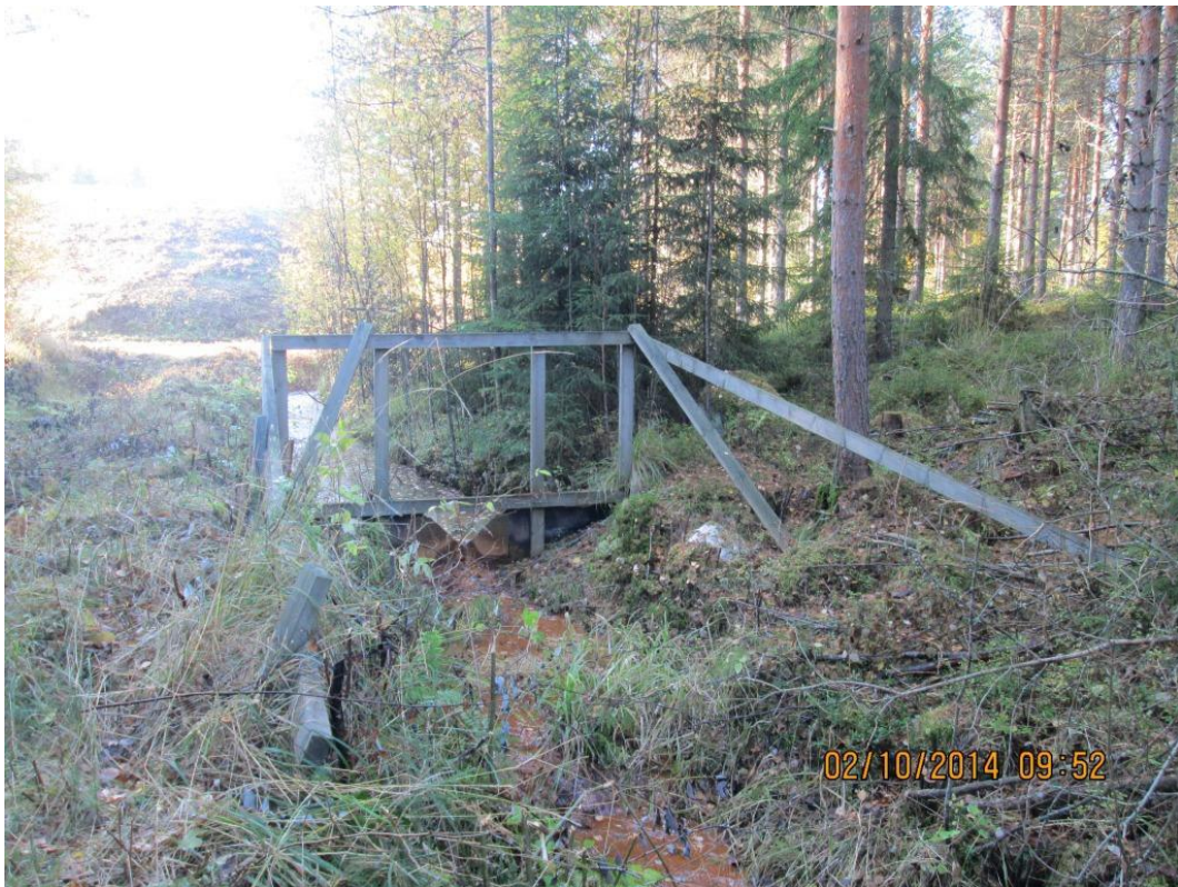
Kuva 52. Paaskallion suljetun kaatopaikan mittapadon ympäristö raivattuna vuonna 2014
