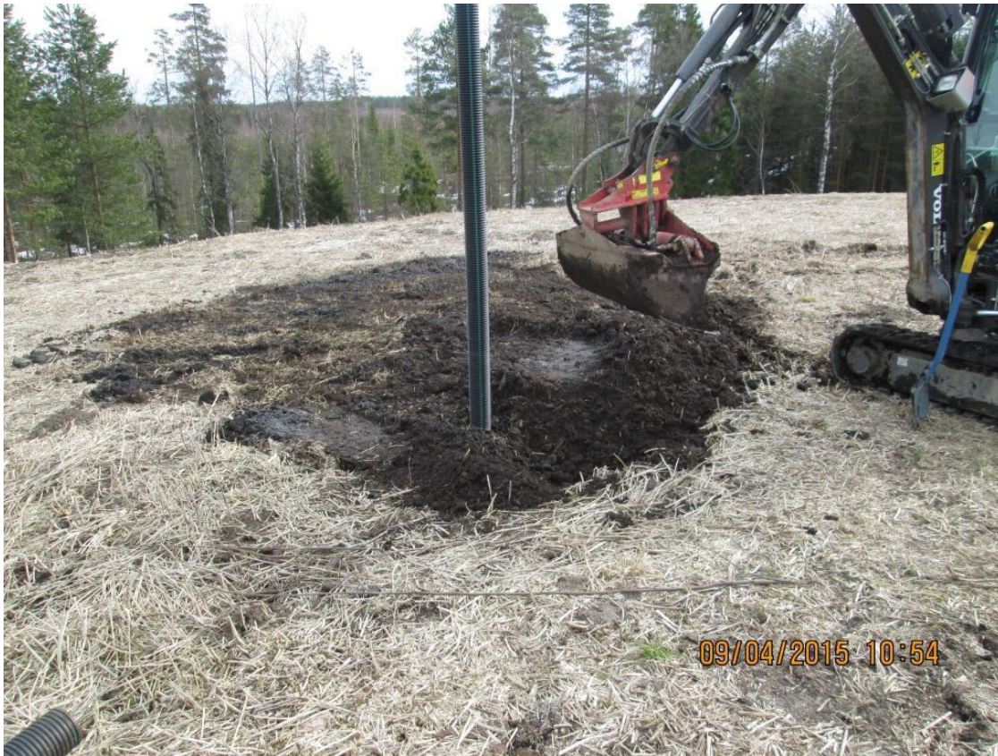
Kuva 35. Katkenneen kaasuntarkkailuputki 2:n korjausta 9.4.2015
