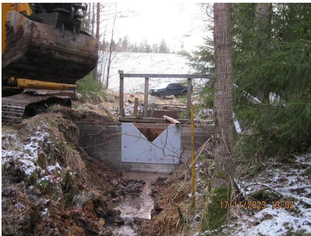
Kuva 71. Suotovesien mittapato uusittiin marraskuussa 2023.
