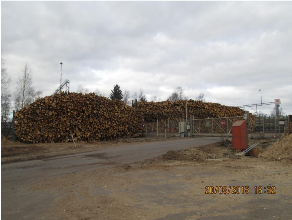
Kuva 138. Meluestepinoja murskauskentän reunalla Koskisen Oyj:n Tehdastien laitosalueella
