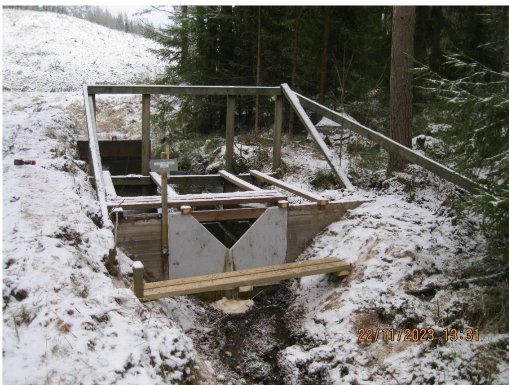
Kuva 72. Suotovesien uusi mittapato valmiina marraskuussa 2023.
