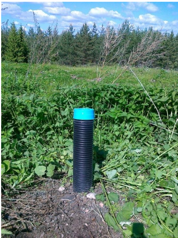
Kuva 31. Kaasuntarkkailuputkeen 2 asennettu tiivis tulppa vuonna 2010
