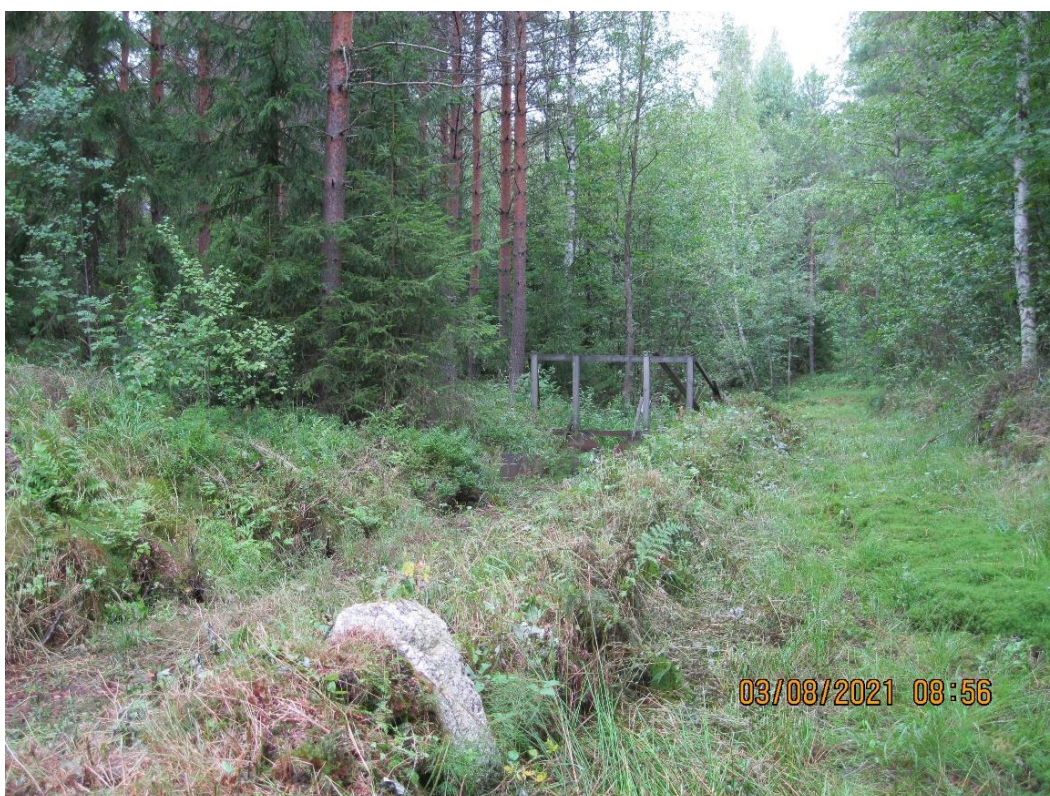
Kuva 54. Paaskallion suljetun kaatopaikan mittapadon ympäristö raivattuna vuonna 2021
