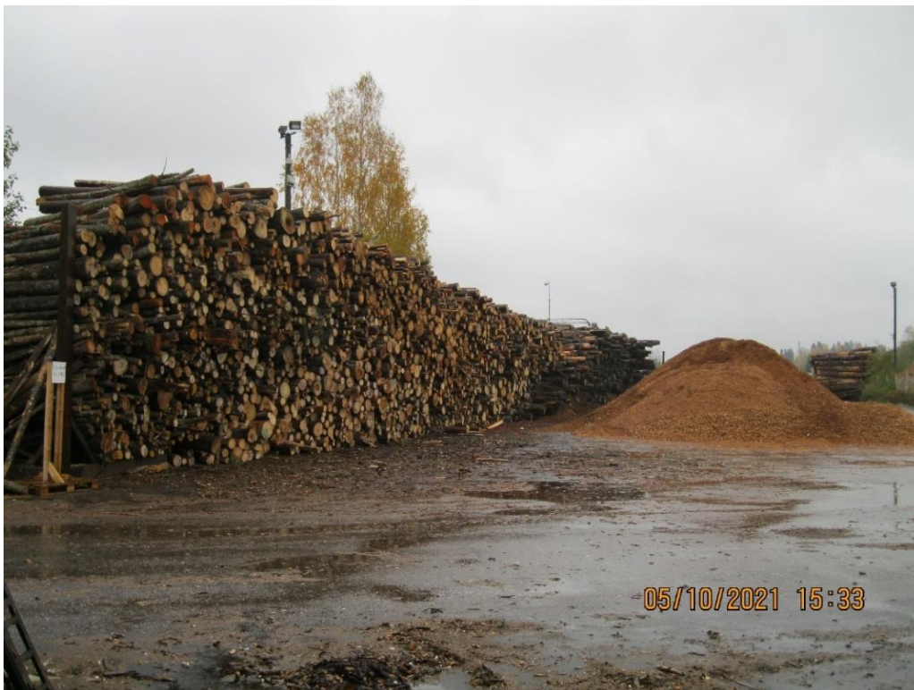
Kuva 139. Meluestepinoja murskauskentän reunalla Koskisen Oyj:n Tehdastien laitosalueella
