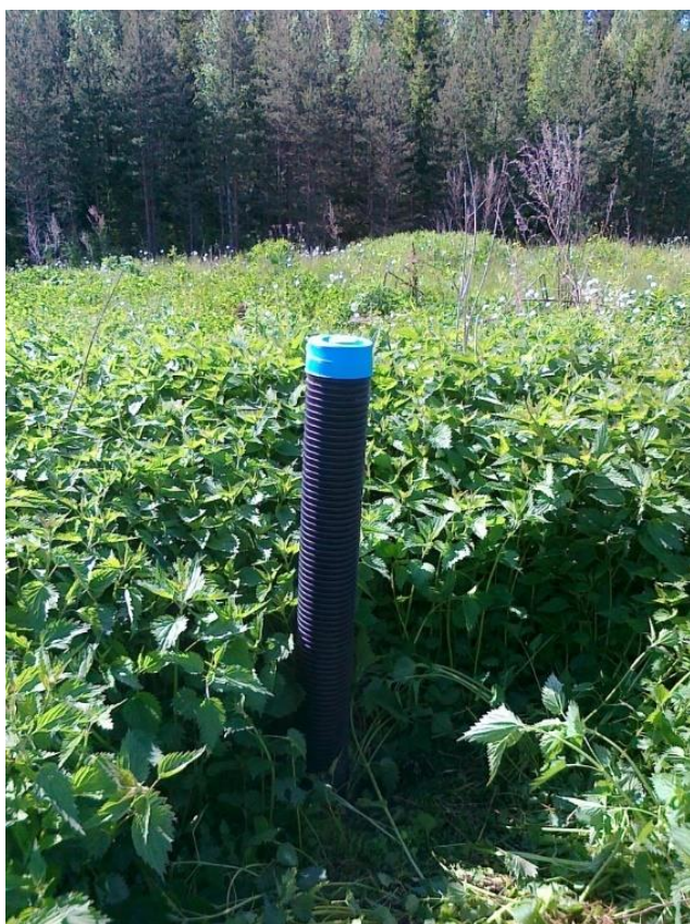
Kuva 30. Kaasuntarkkailuputkeen 1 asennettu tiivis tulppa vuonna 2010
