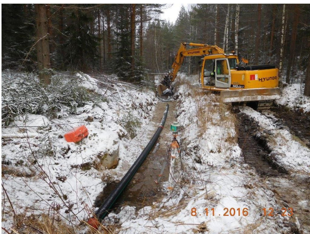
Kuva 64. Suotovesiojaan asennettu rumpuputki marraskuussa 2016.
