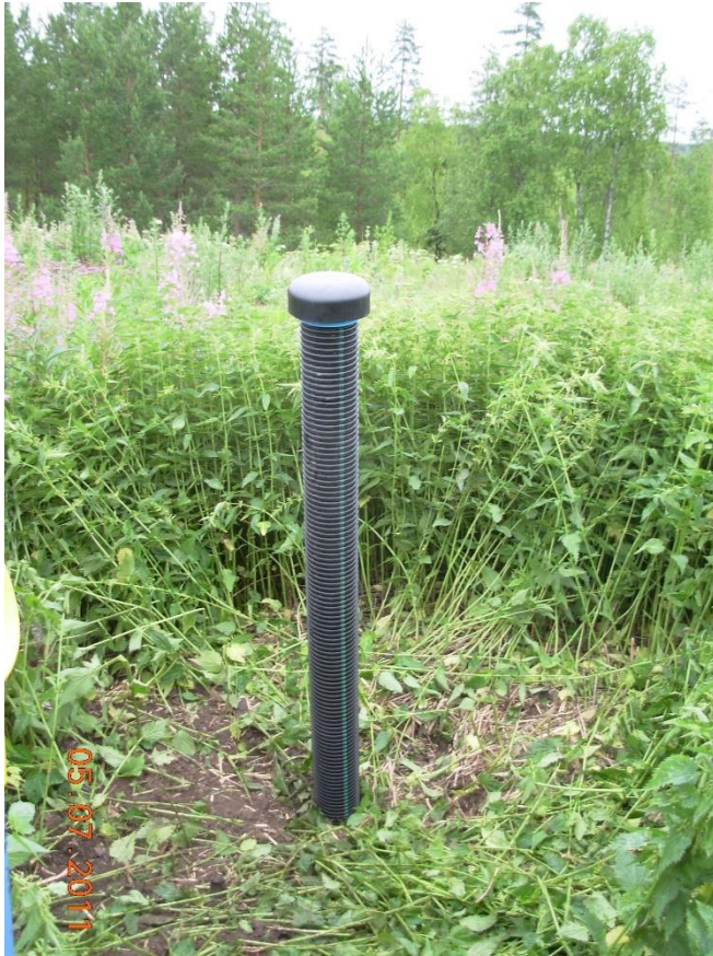
Kuva 33. Katkennut kaasuntarkkailuputki 2 korjattuna 5.7.2011
