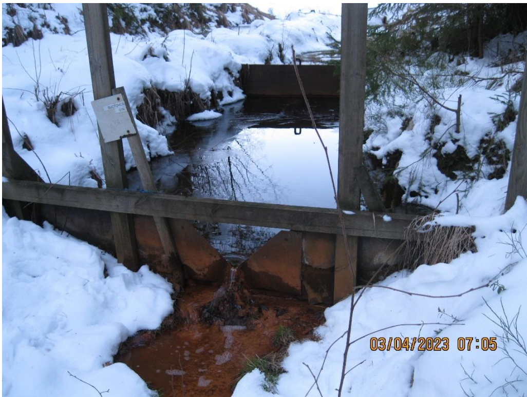
Kuva 70. Suotovesien "kokooma-allas" ja mittapato huhtikuussa 2023.
