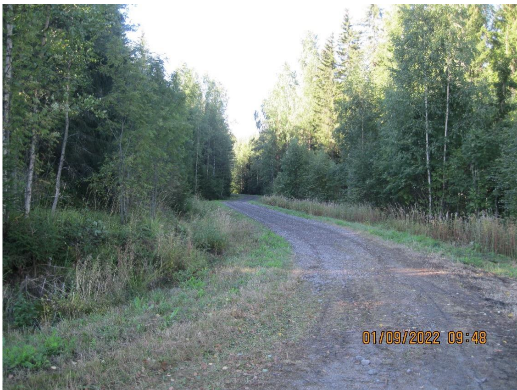
Kuva 62. Paaskallion suljetun kaatopaikan tienpintaan levitetty 0 – 32 mm soramurske vuonna 2022
