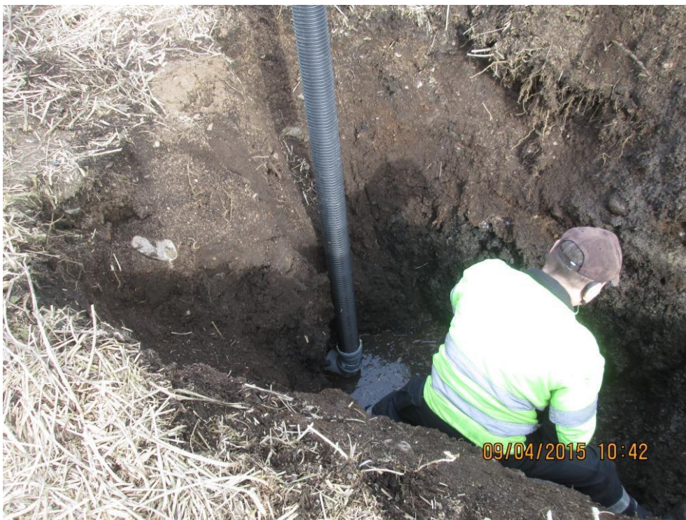
Kuva 34. Katkenneen kaasuntarkkailuputki 2:n korjausta 9.4.2015
