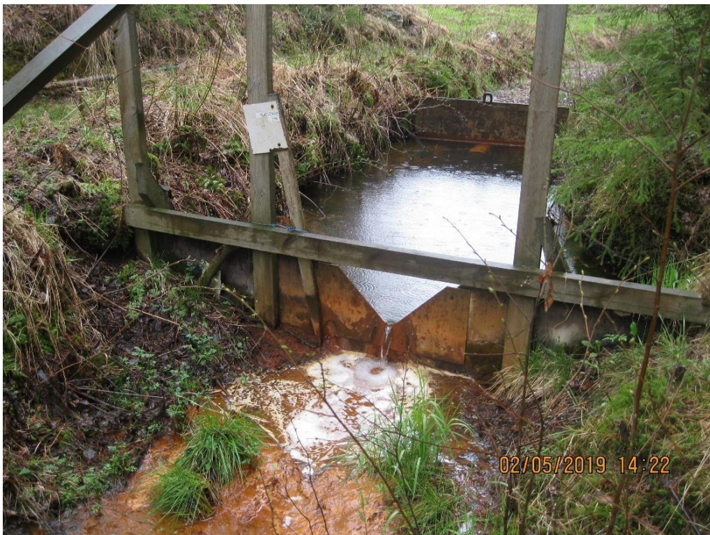
Kuva 66. Suotovesien "kokooma-allas" ja mittapato toukokuussa 2019
