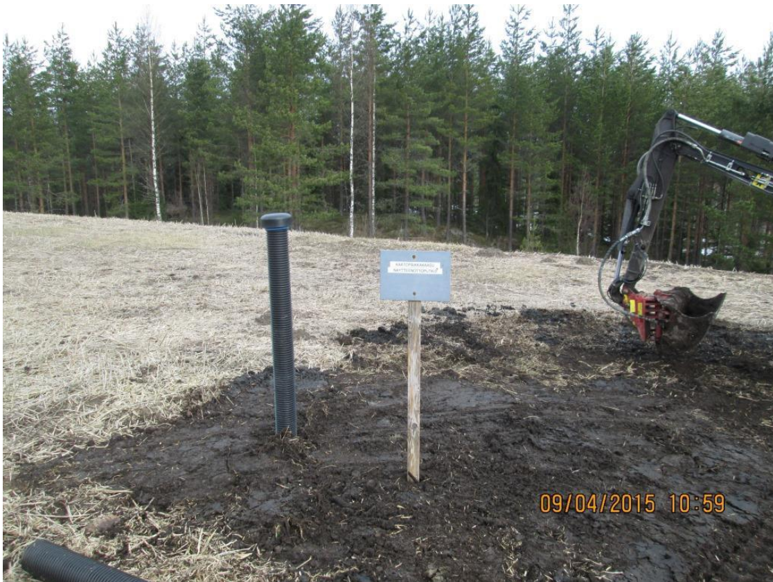
Kuva 36. Katkennut kaasuntarkkailuputki 2 korjattuna 9.4.2015
